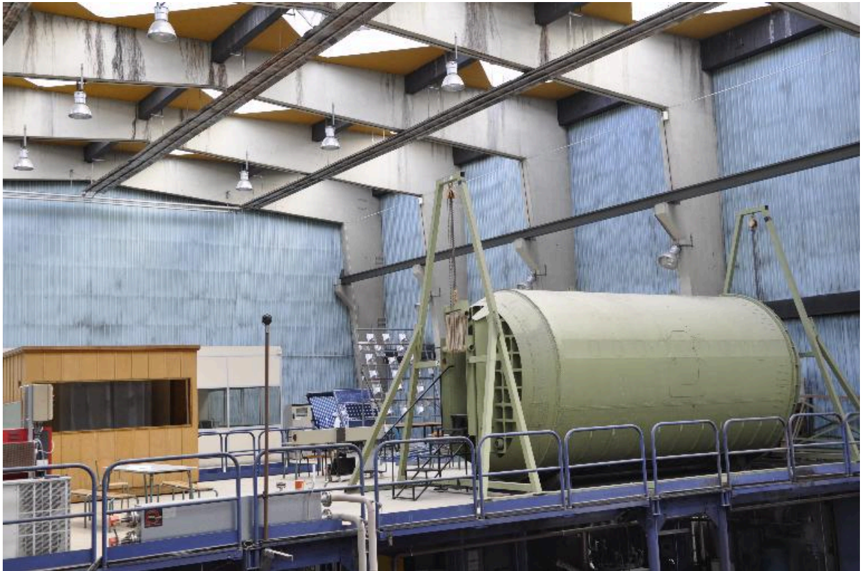
Détail de la mezzanine de la halle
