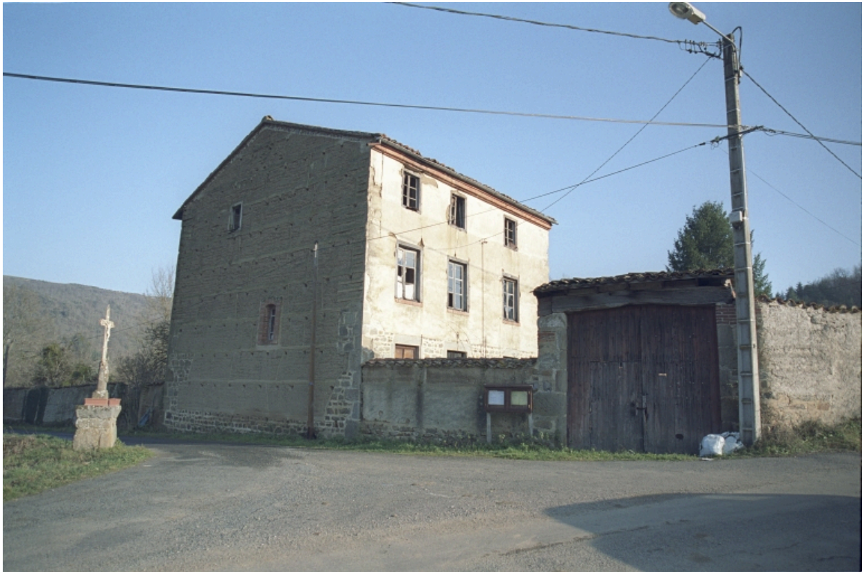
Débats-Rivières-d'Orpra, le Martel (1987 A2 1048), type A1. Vue d'ensemble de la ferme depuis l'extérieur de la cour.
