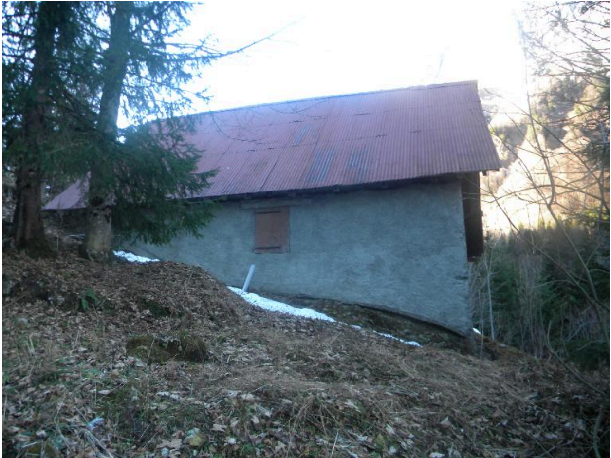
Vue de la façade arrière.
