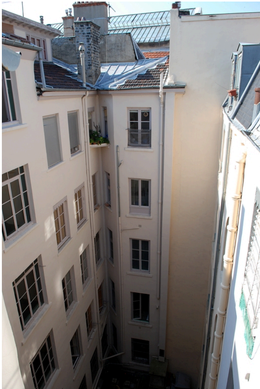
Elévations sur cour depuis l'escalier de l'immeuble sis 15 rue Gasparin
