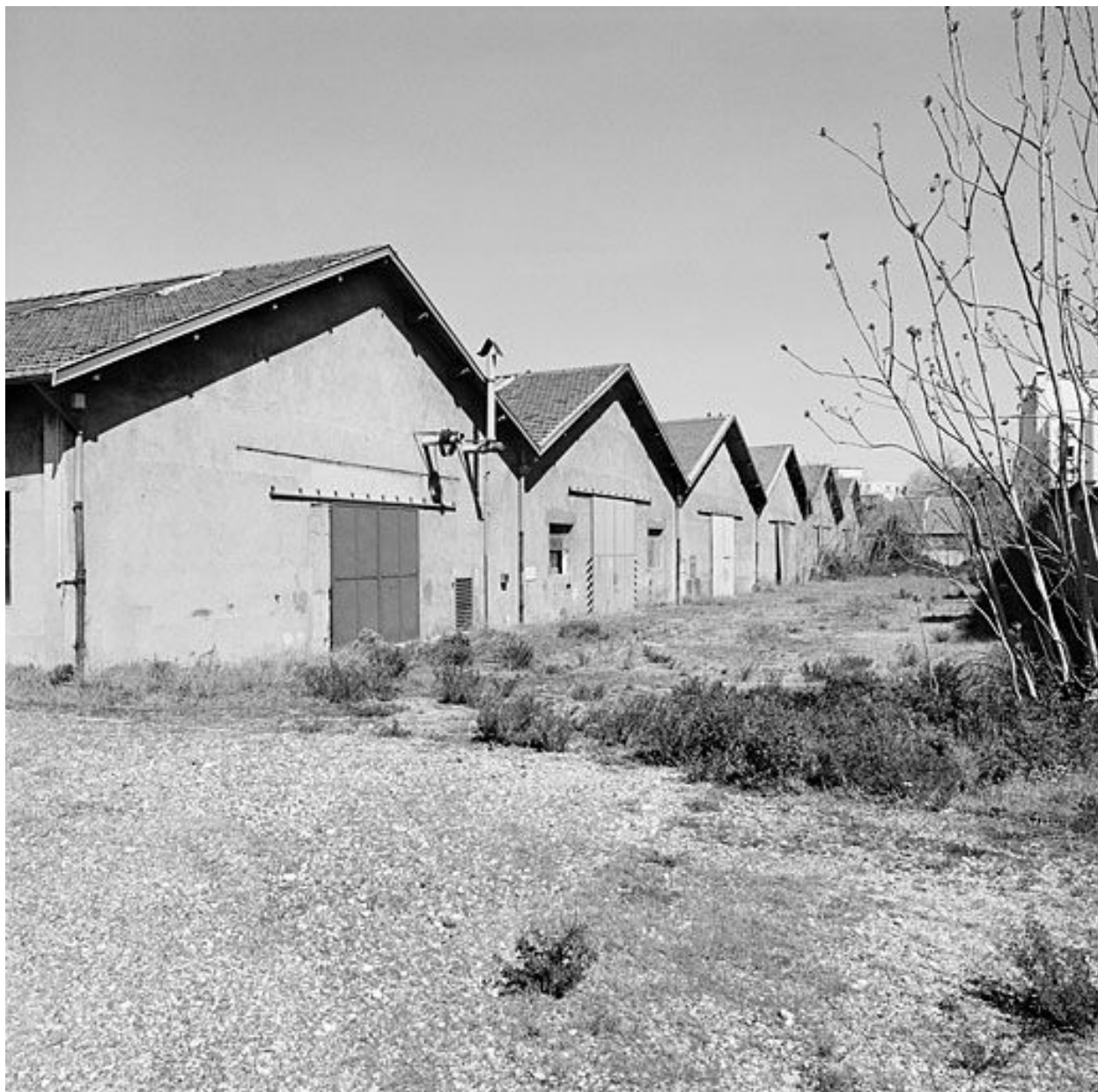
Entrepôts: bâtiment 2 vue postérieure
