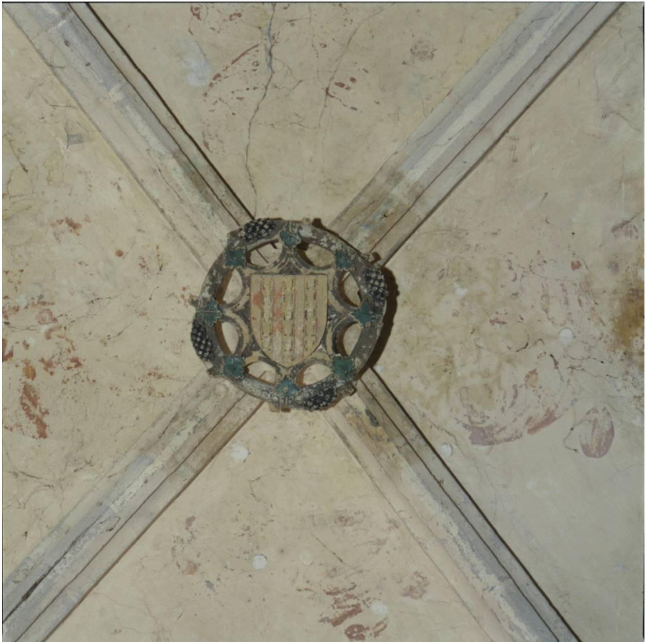
Clef de voûte aux armes des Langeac, troisième travée de la nef (c).
