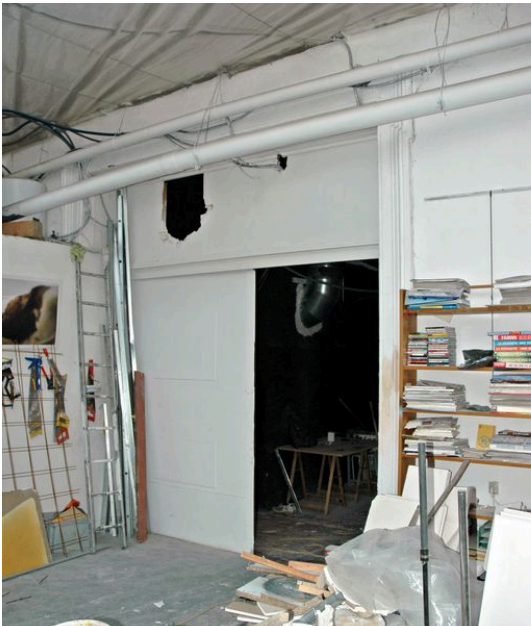
Vestiges d'encadrement de porte, pièce nord du corps de bâtiment nord-ouest
