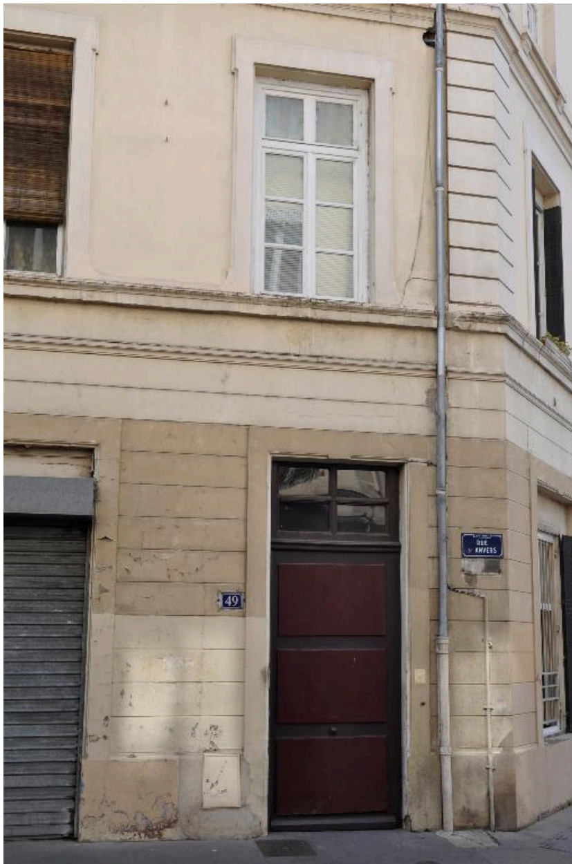
Vue rapprochée de la porte, à l'extrémité de la façade sur rue d'Anvers
