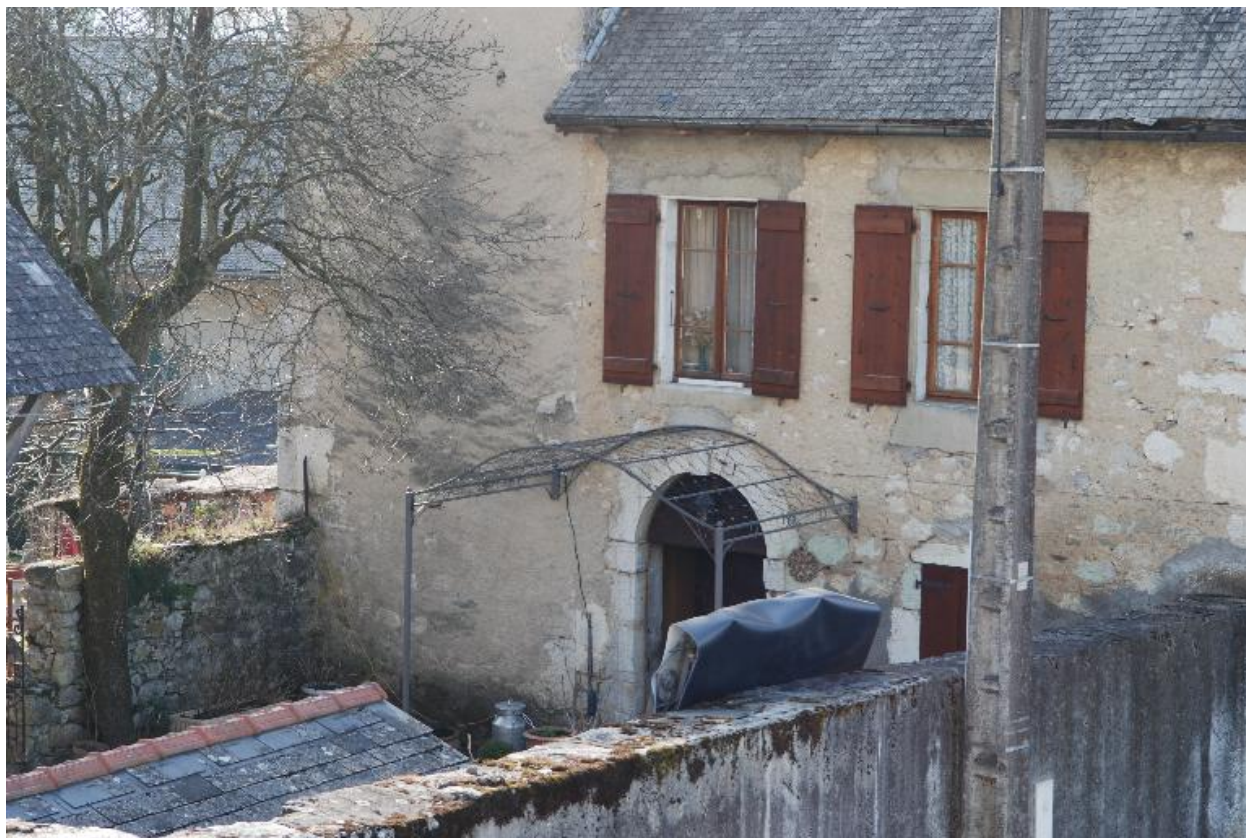
Détail de la façade est
