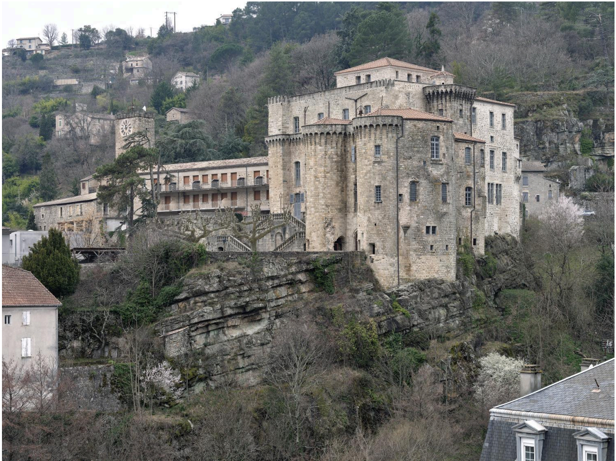
Vue générale depuis l'est
