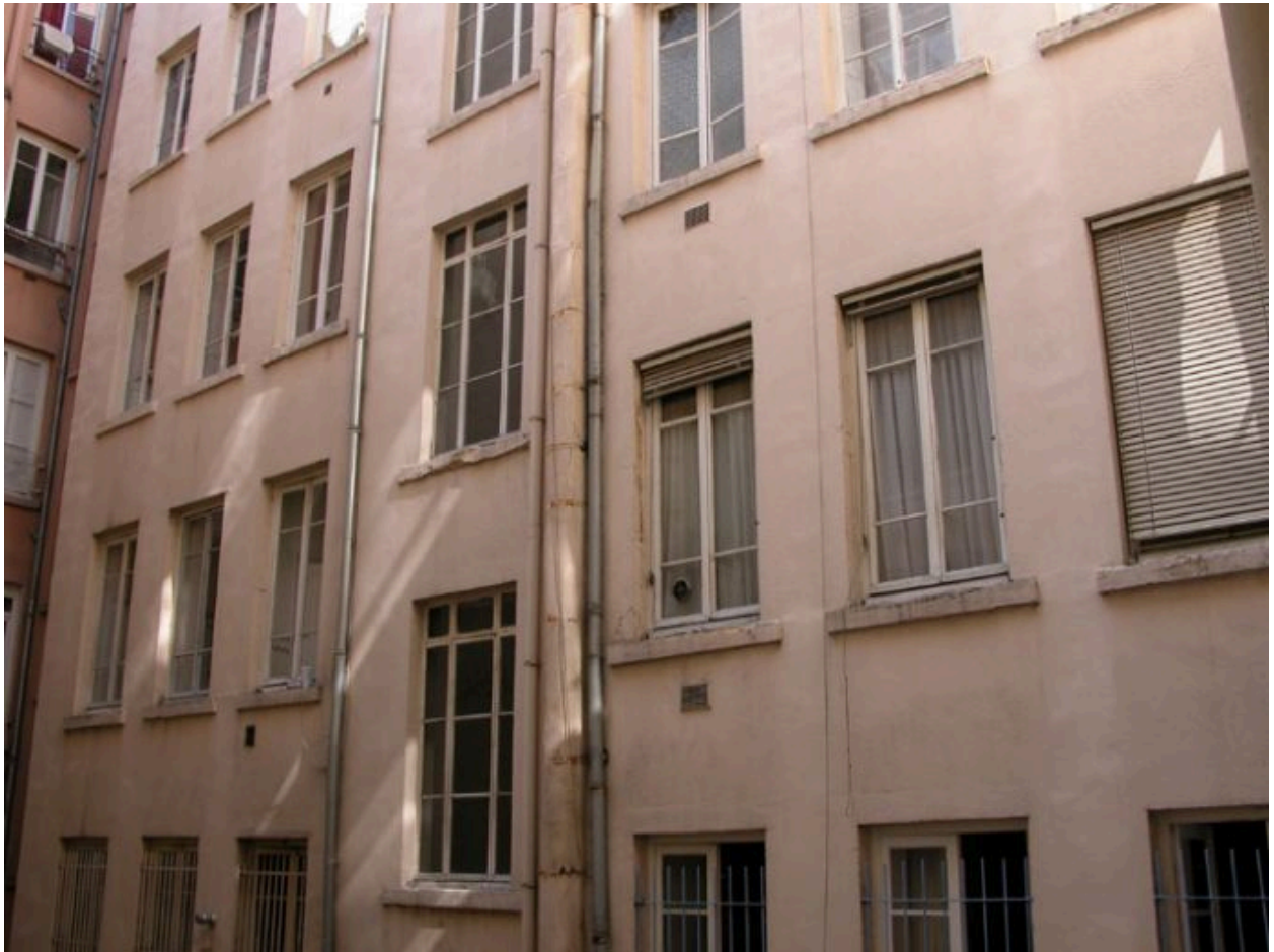
Elévation sur cour
