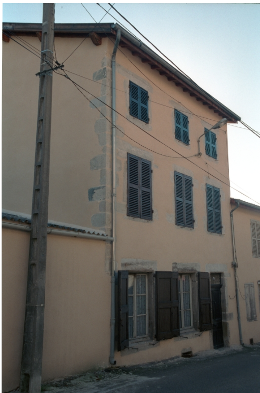
Boën, îlot 13, Ph. Raymond (rue) 26. Vue générale de la façade sur rue.
