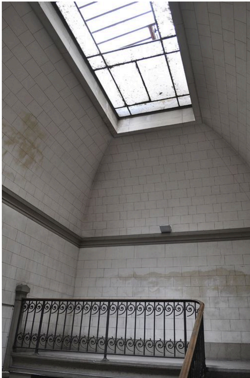
Cage d'escalier nord, verrière.
