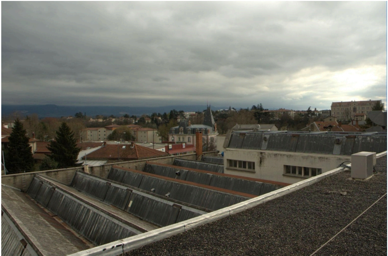
Vue zénithale des ateliers sheds
