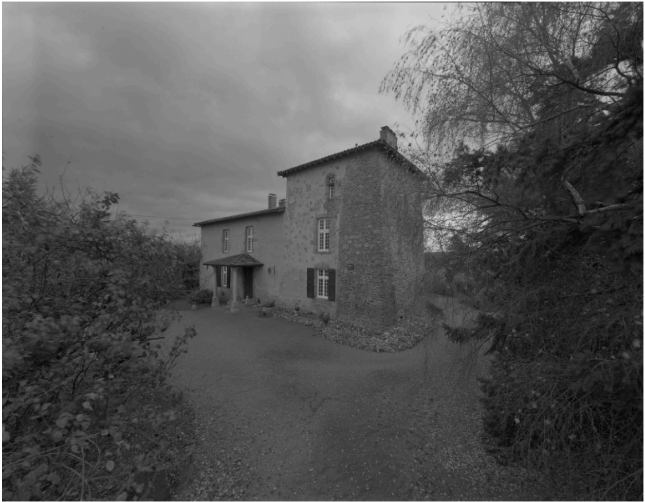
Vue générale de l'élévation principale.
