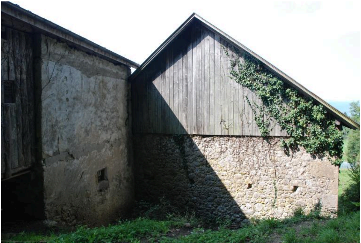
Vue d'ensemble du mur pignon ouest du Grenier.
