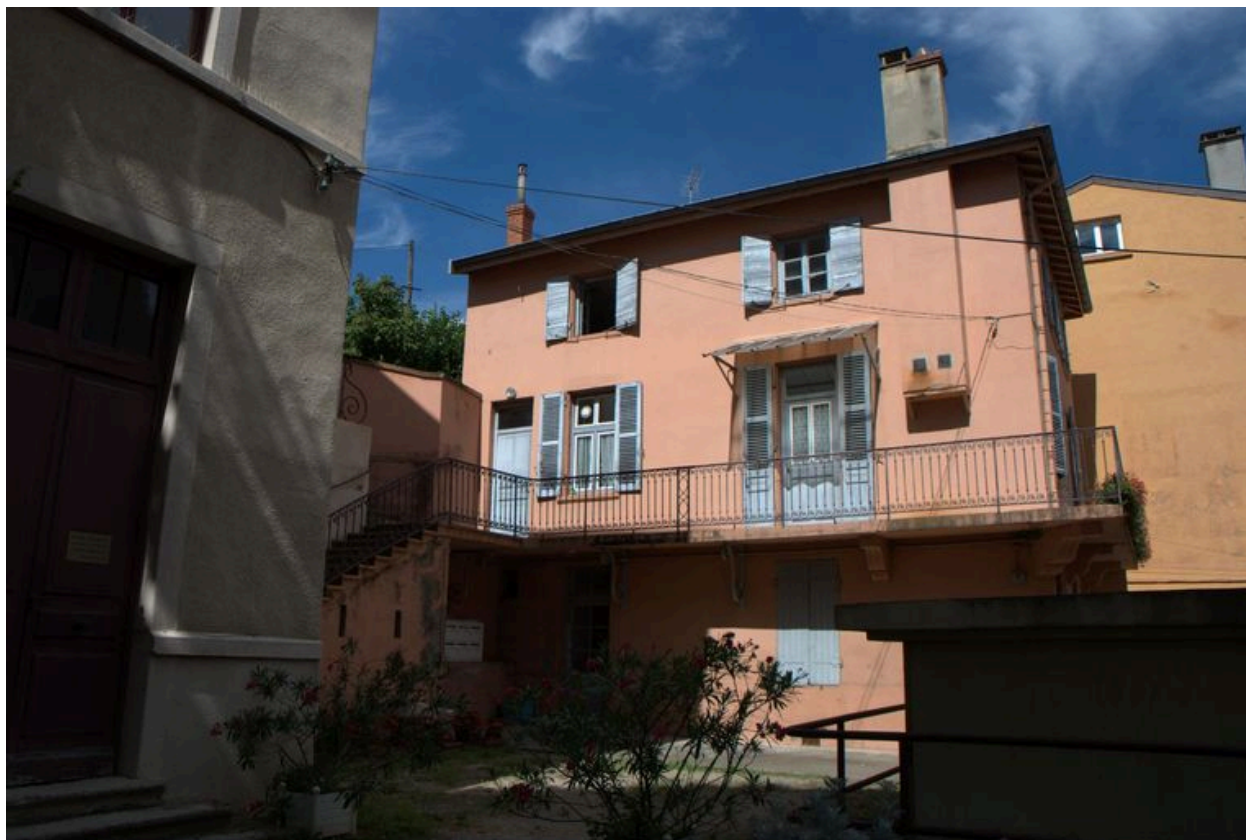
Vue de l'élévation sud
