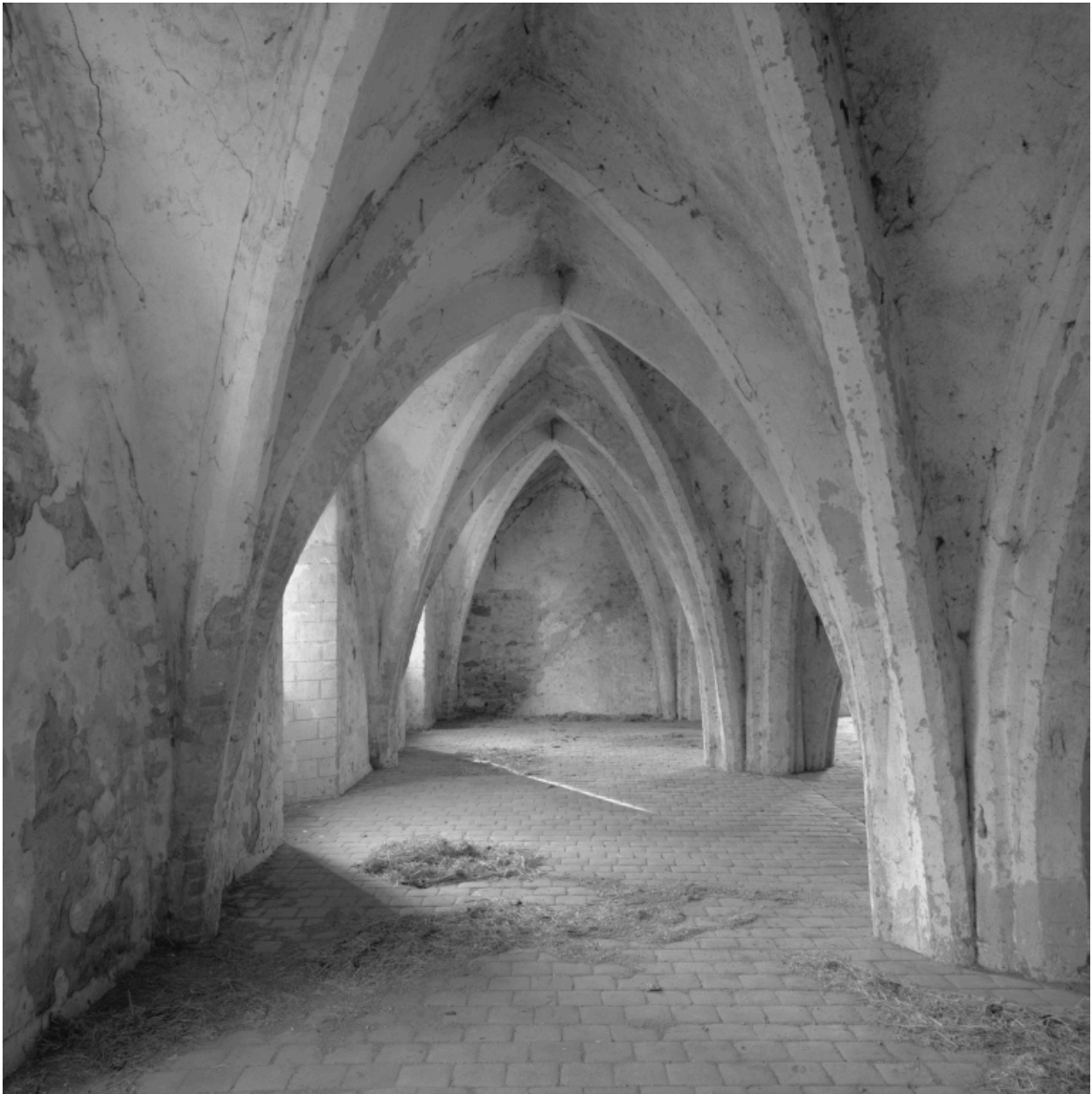
Vue d'ensemble intérieure du bas-côté sud, vers l'ouest.
