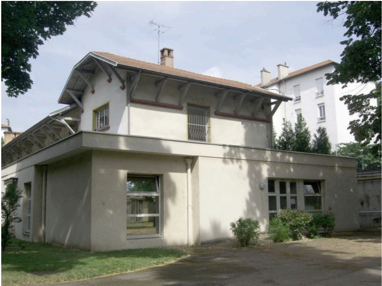
Batiment Nord Ouest, élévation postérieure
