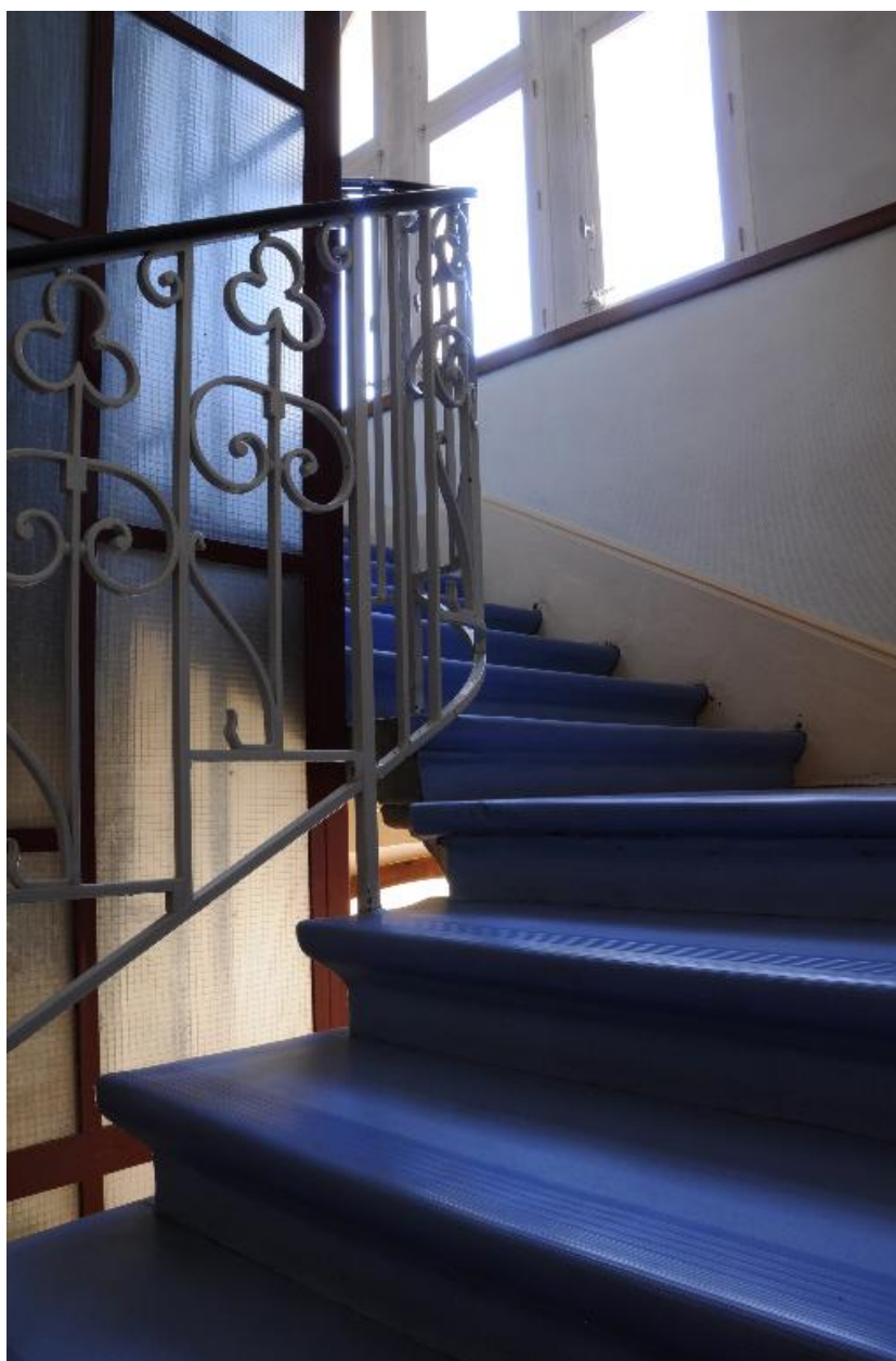
Escalier intérieur, rampe et cage d'ascenseur
