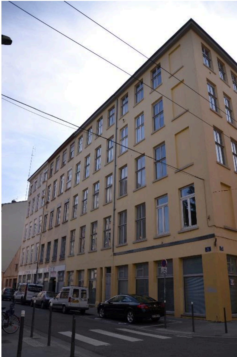
Vue d'ensemble façade nord
