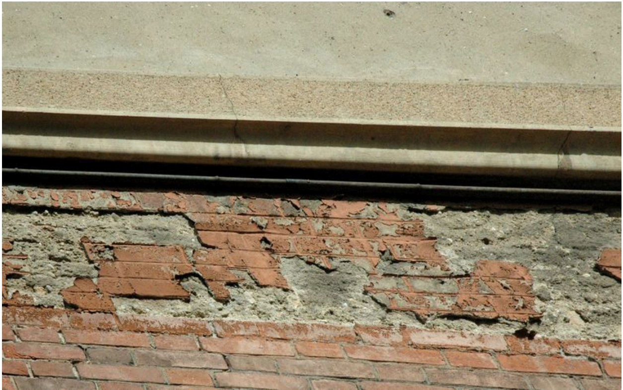
Gymnase, élévation antérieure, détail du parement
