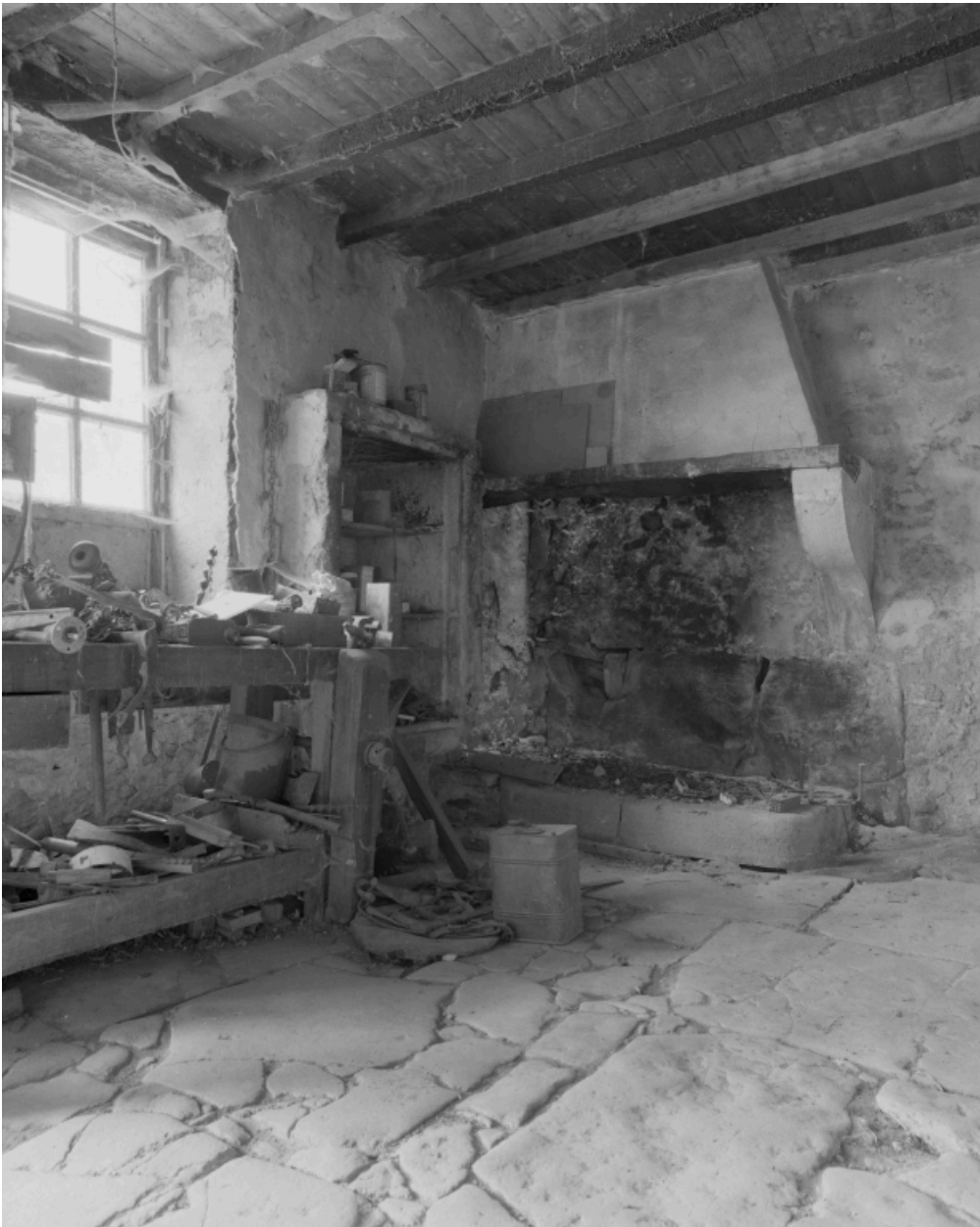
Basses Condamines, chemin de Taulignan aux carrières. Détail de l'ancien logis : cheminée, placard mural et dalles de pierre.
