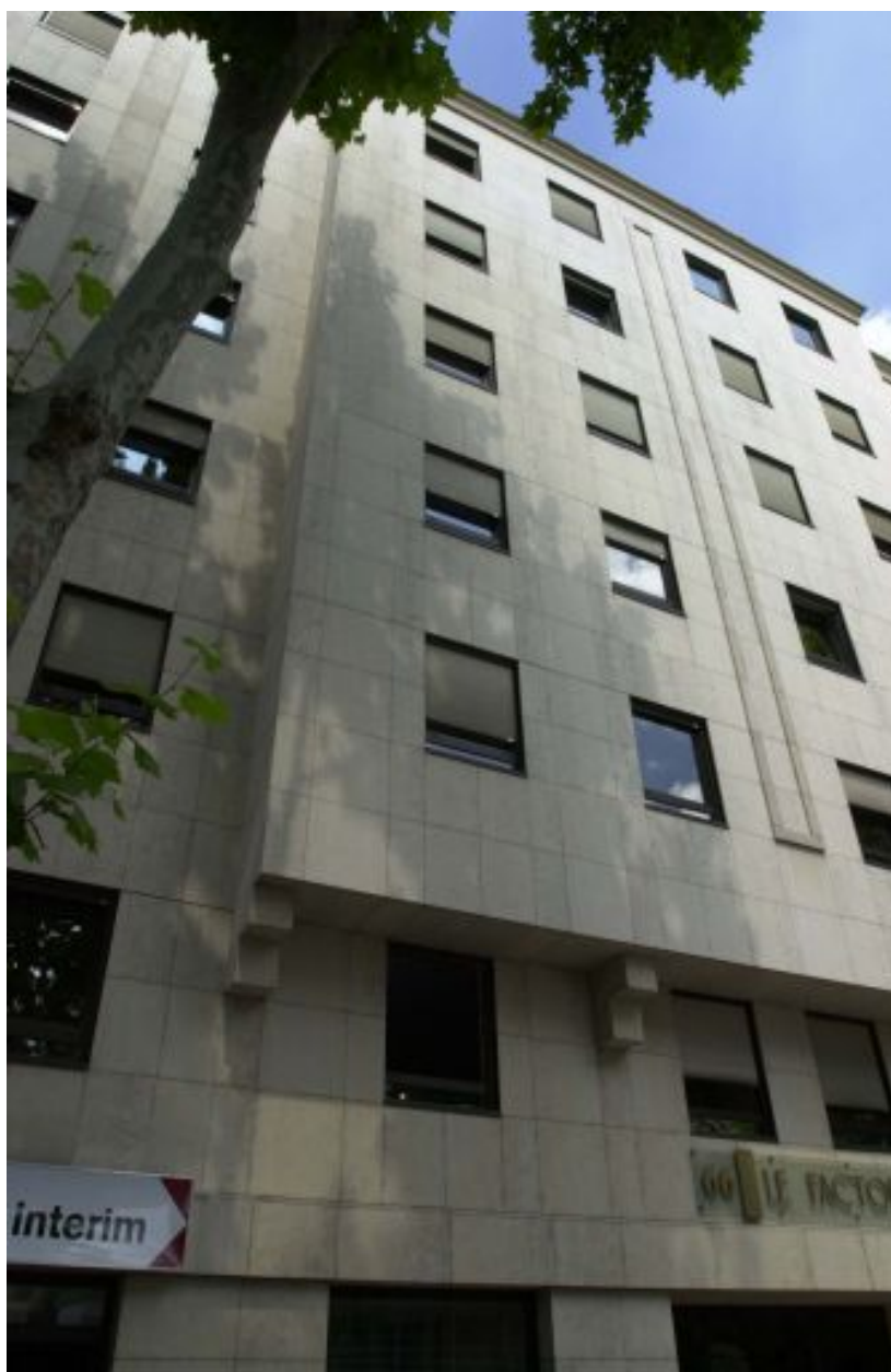
Détail de l'avant-corps en encorbellement
