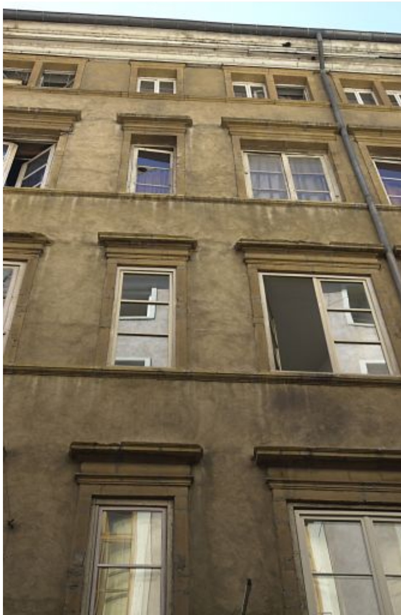
Façade principale, détail de l'élévation
