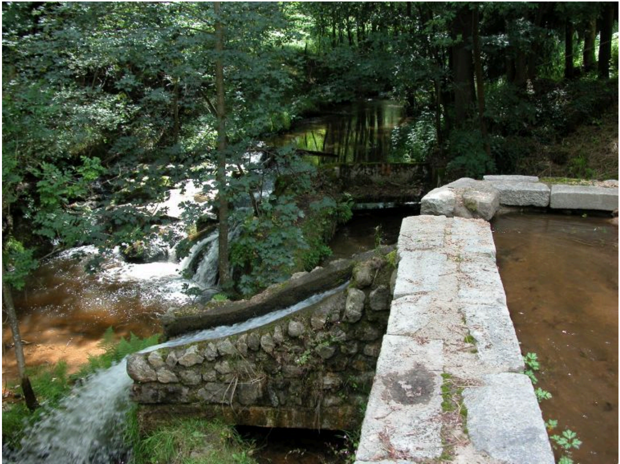
Ancien système de dérivation avec bassin. Ecoulement de l'eau hors du bassin.
