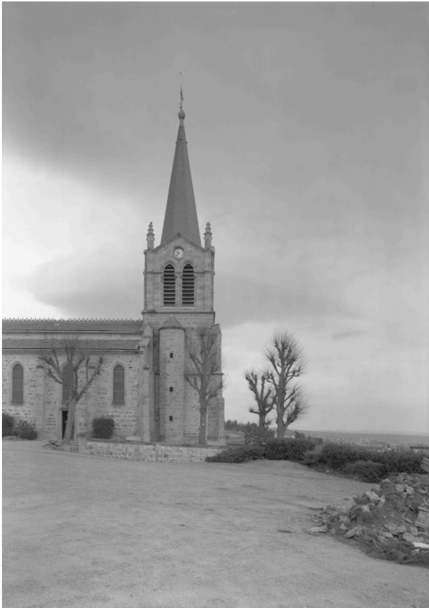
Vue de la façade latérale gauche, détail du clocher-porche.
