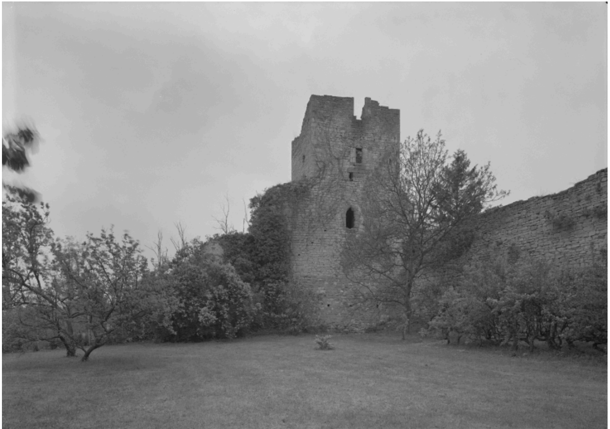
Mur de fortification et tour en fer à cheval.
