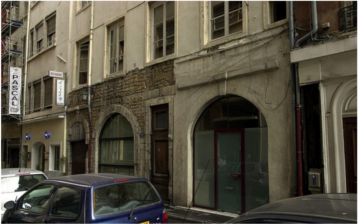
Au fond, les rez-de-chaussée et premier étage
