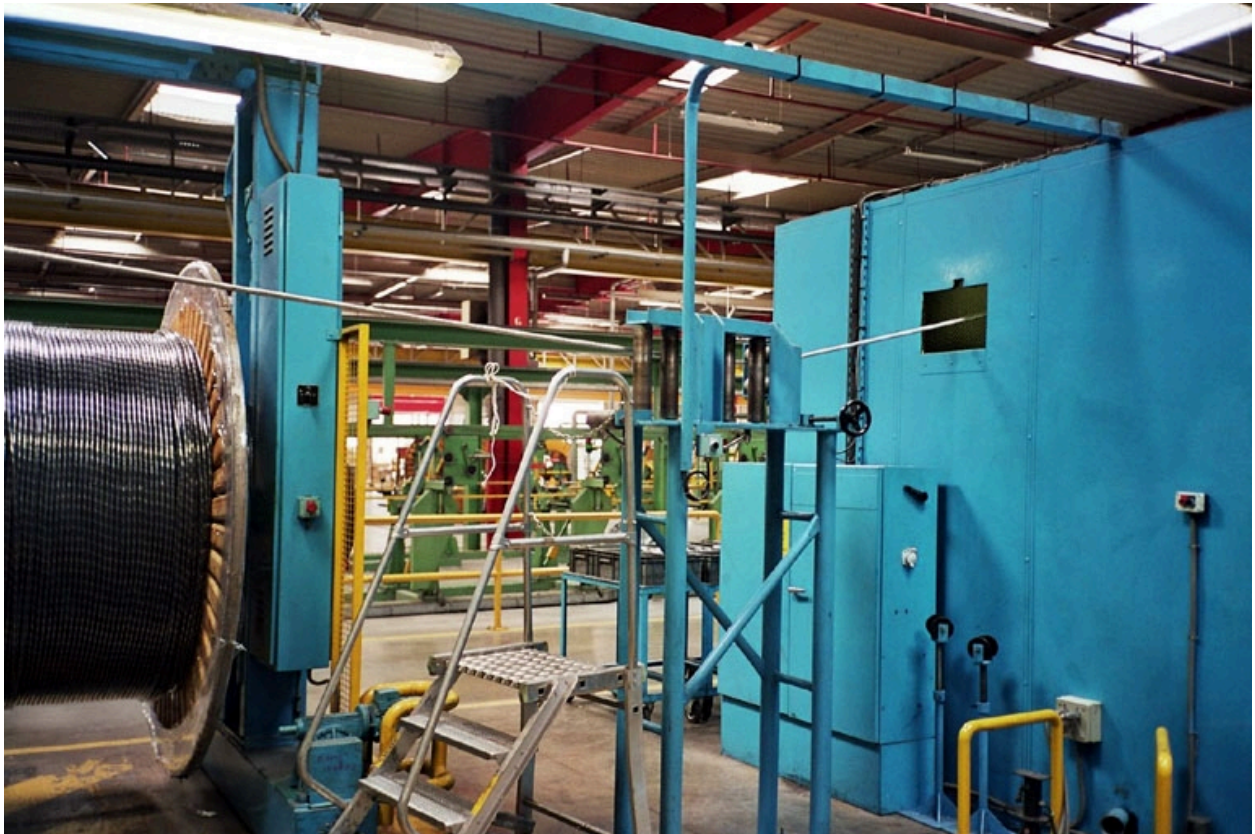
Tresseuse : sortie de câble
