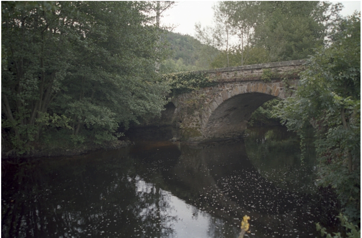
Vue d'ensemble du pont au-dessus du Lignon.
