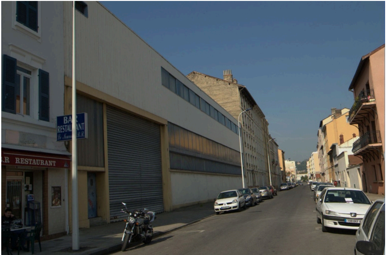
Façade localisée rue Raclet
