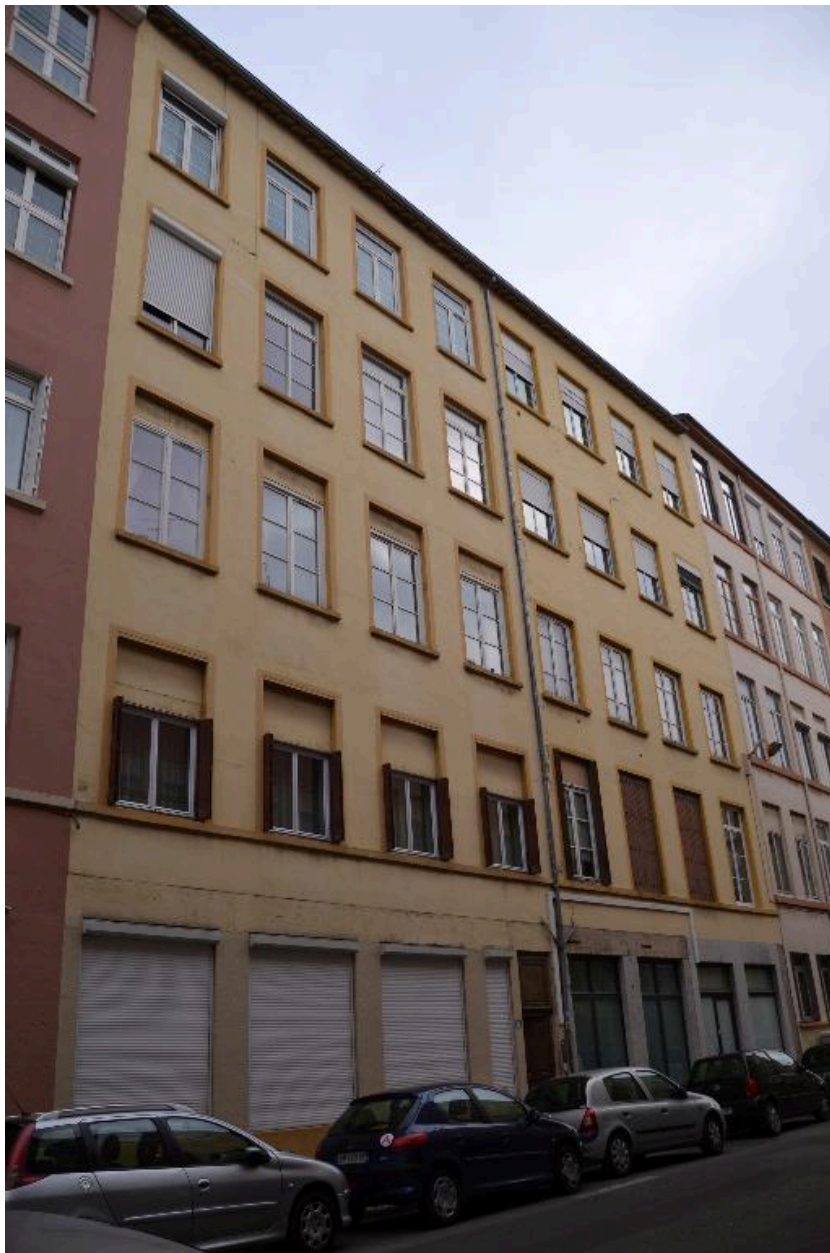
Vue d'ensemble façade sud
