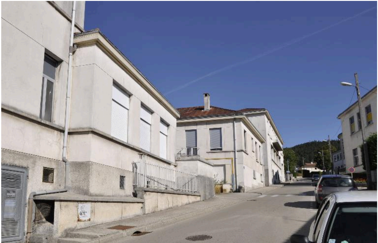
Elévations latérales ouest rue du Stand, depuis le nord
