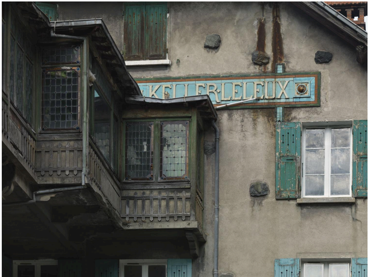
Détail enseigne en façade principale "Keller et Leleux" et galerie fermée.
