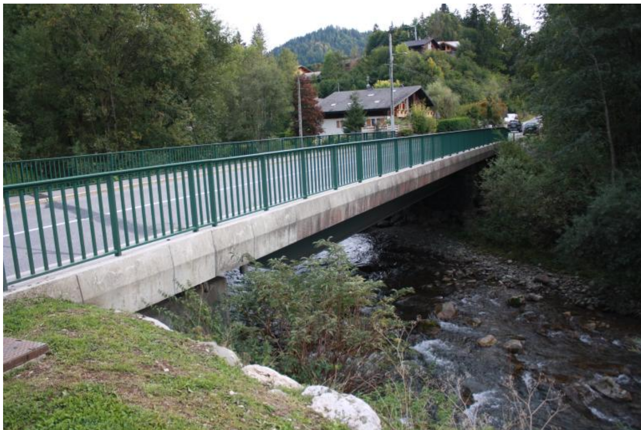
Pont des Plagnettes, face aval
