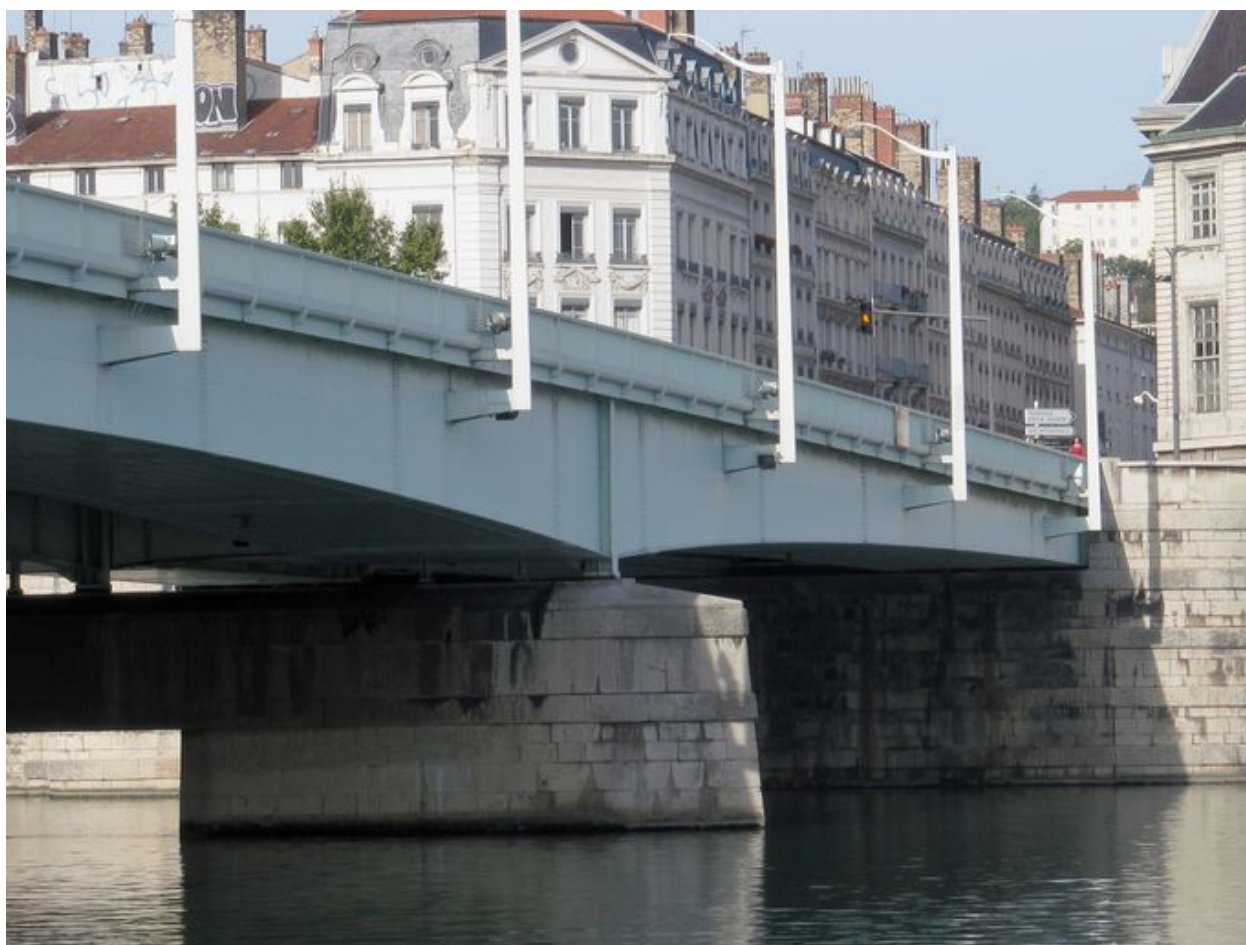
Vue partielle, travée droite et culée, face amont (depuis la rive gauche)
