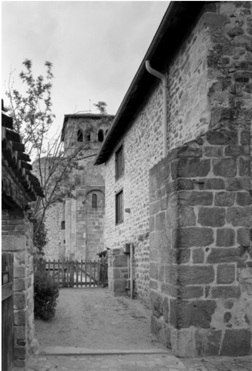
Vue de l'extrémité est de l'aile nord, depuis le nord.
