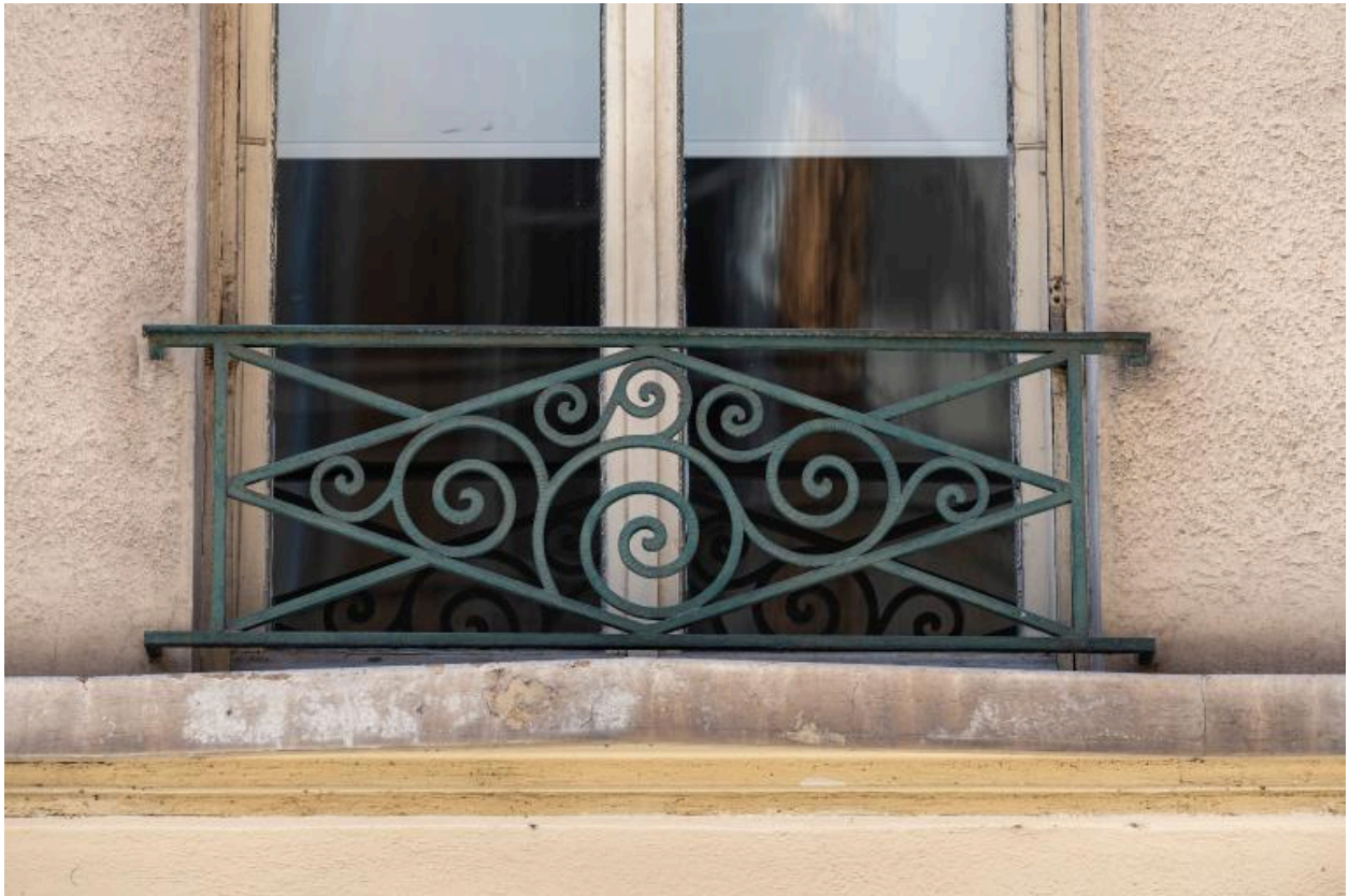
Détail d'un garde-corps
