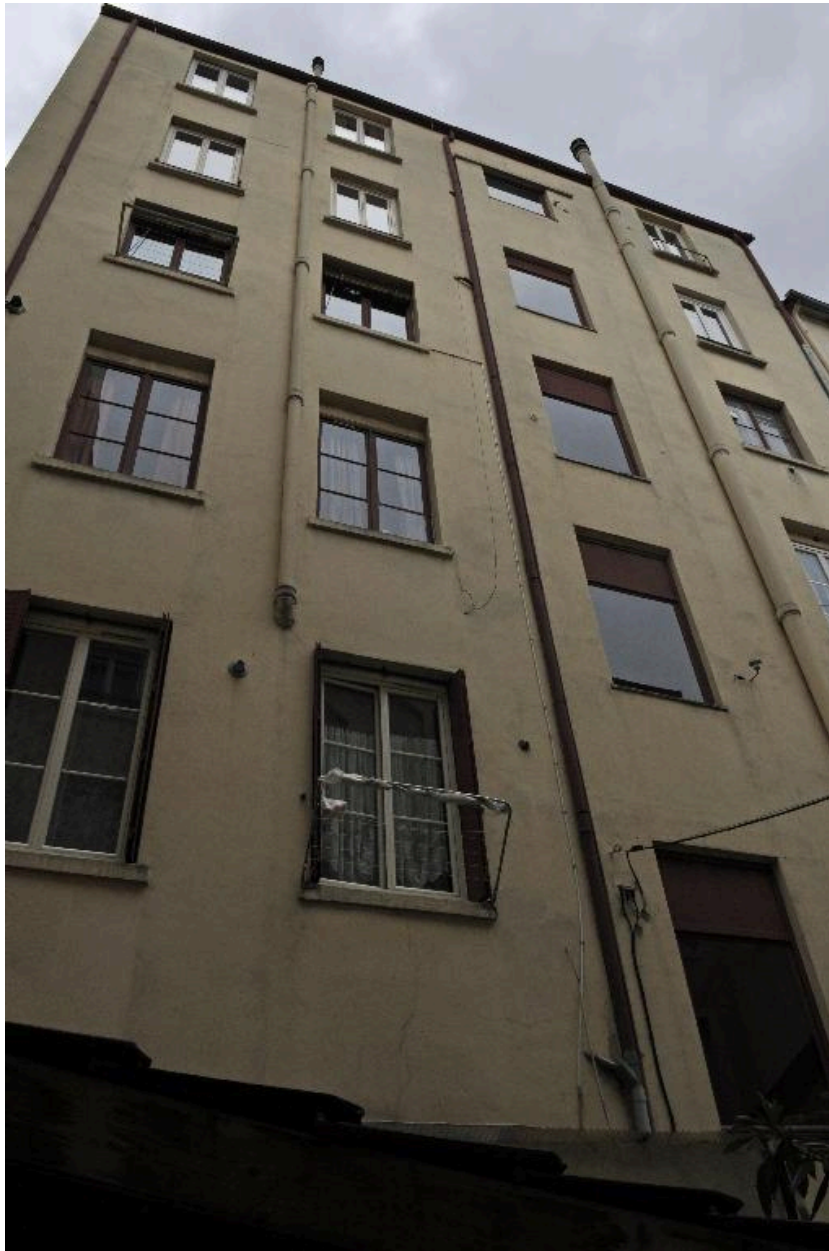
Immeuble sur cour, vue partielle
