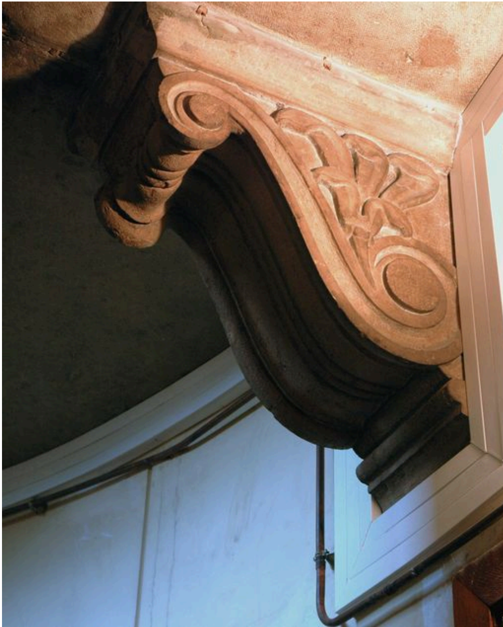
Détail des consoles supportant les paliers
