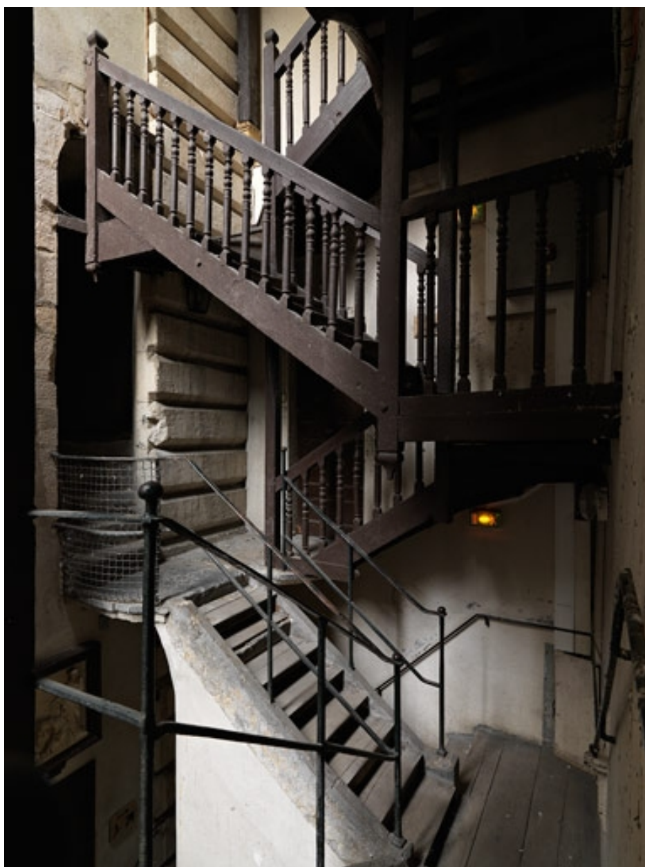
Bâtiment R. L'escalier extérieur
