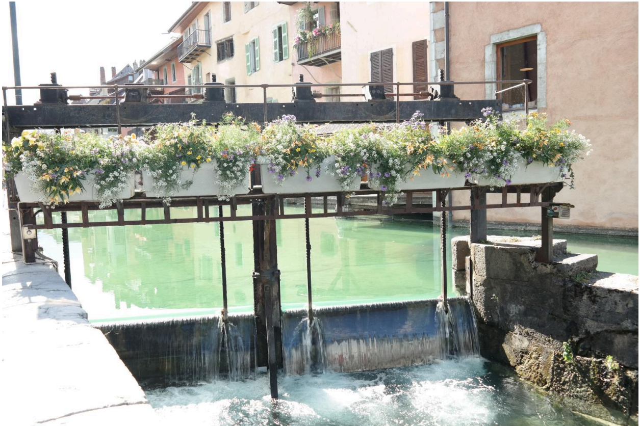
Ecluse en amont du Pont de la République
