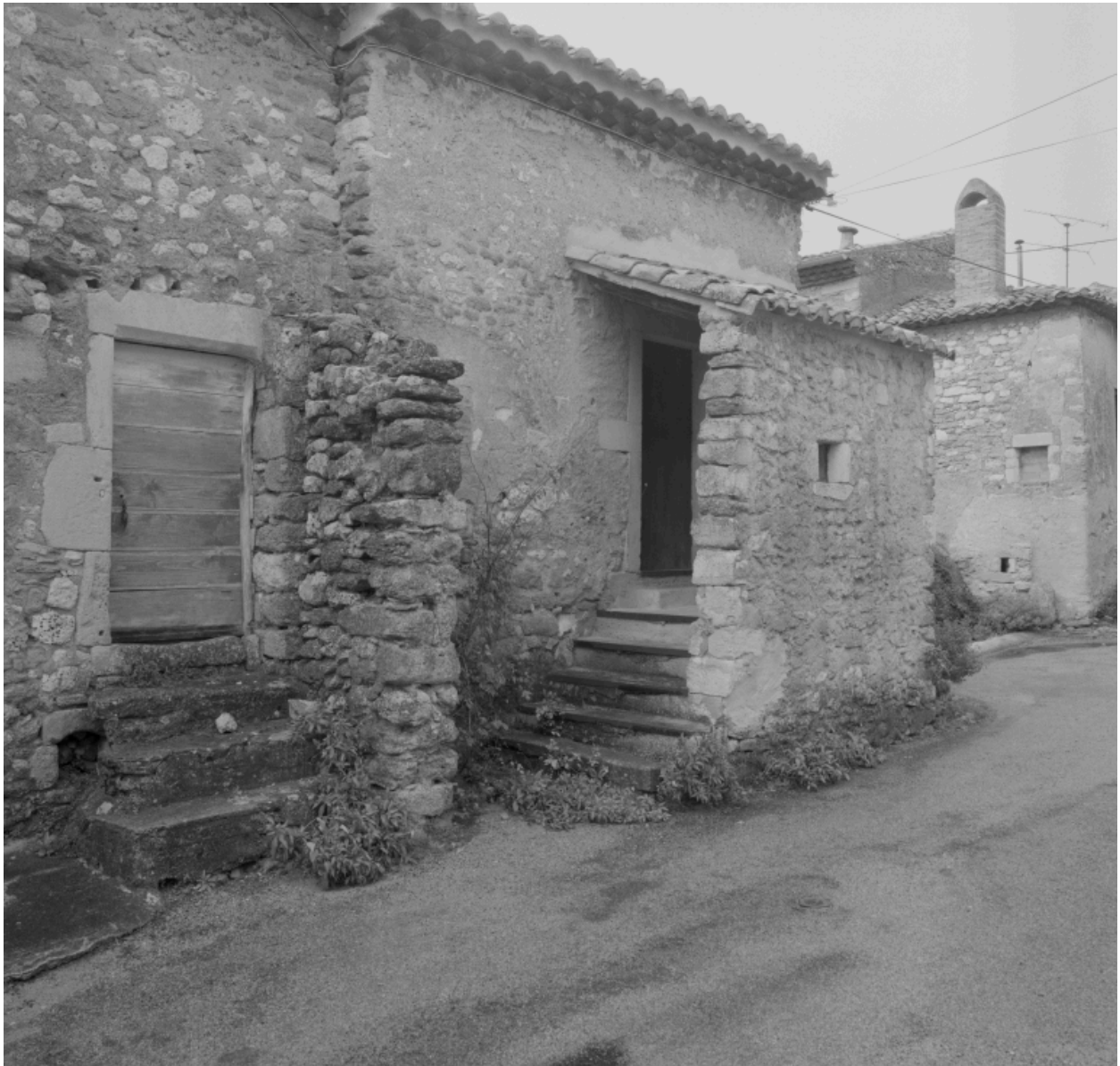
Une maison de la grande rue (F2 686). L'entrée du logis est protégée par un mur coupe-vent contre le mistral, typique de Réauville.
