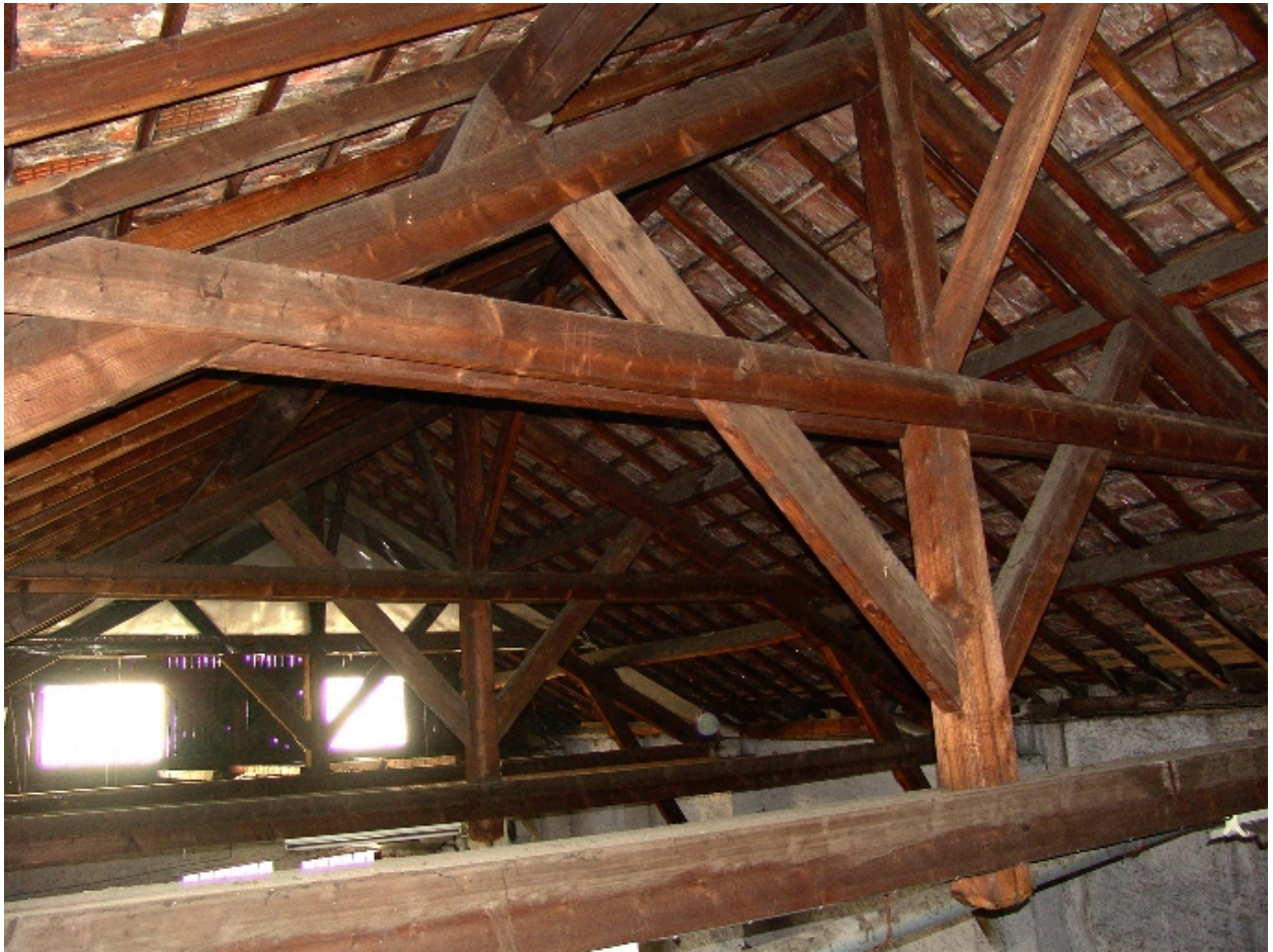
Garage de réparations automobiles : charpente de l'atelier
