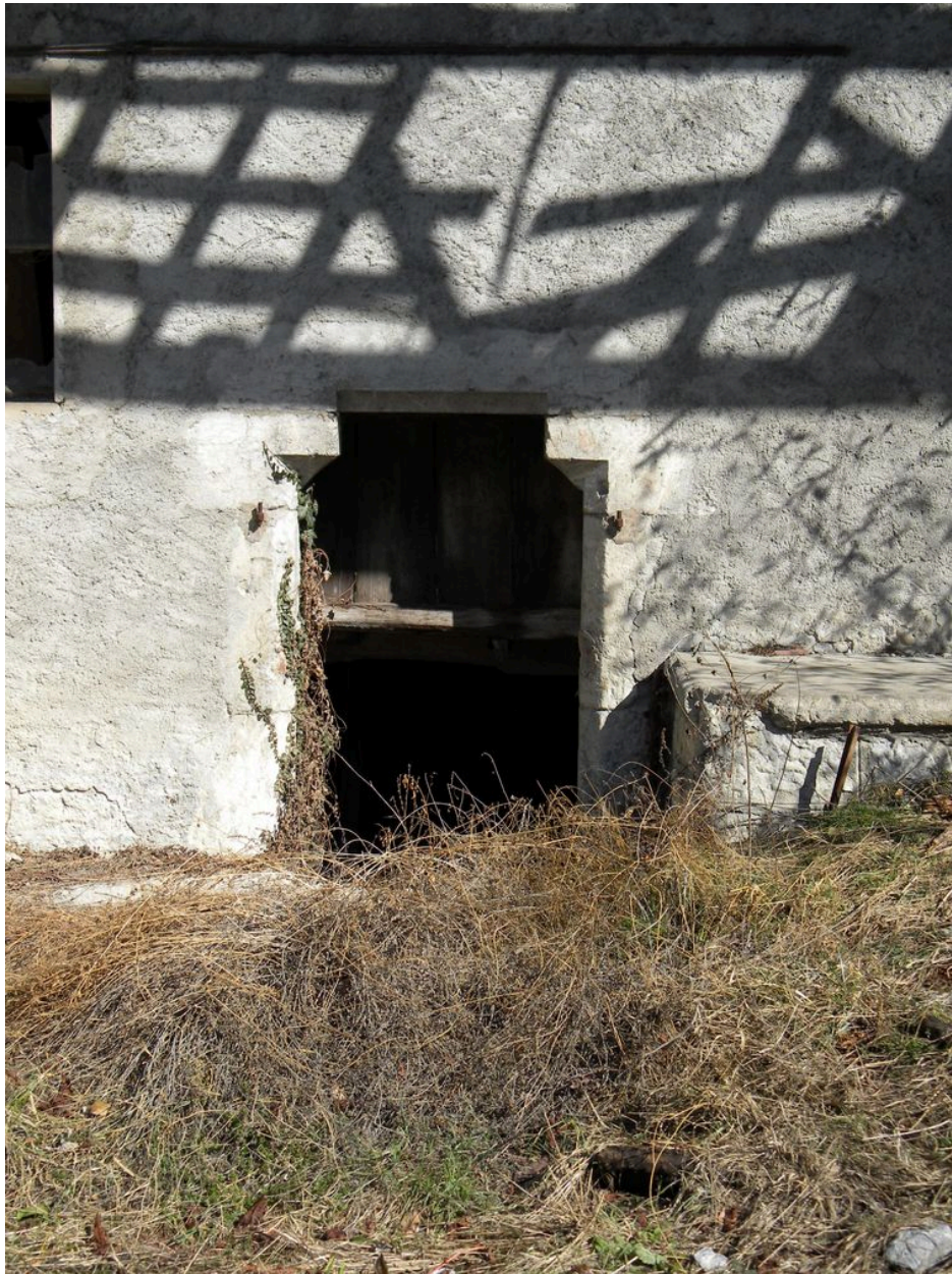
Vue de la porte avec linteau échancré.
