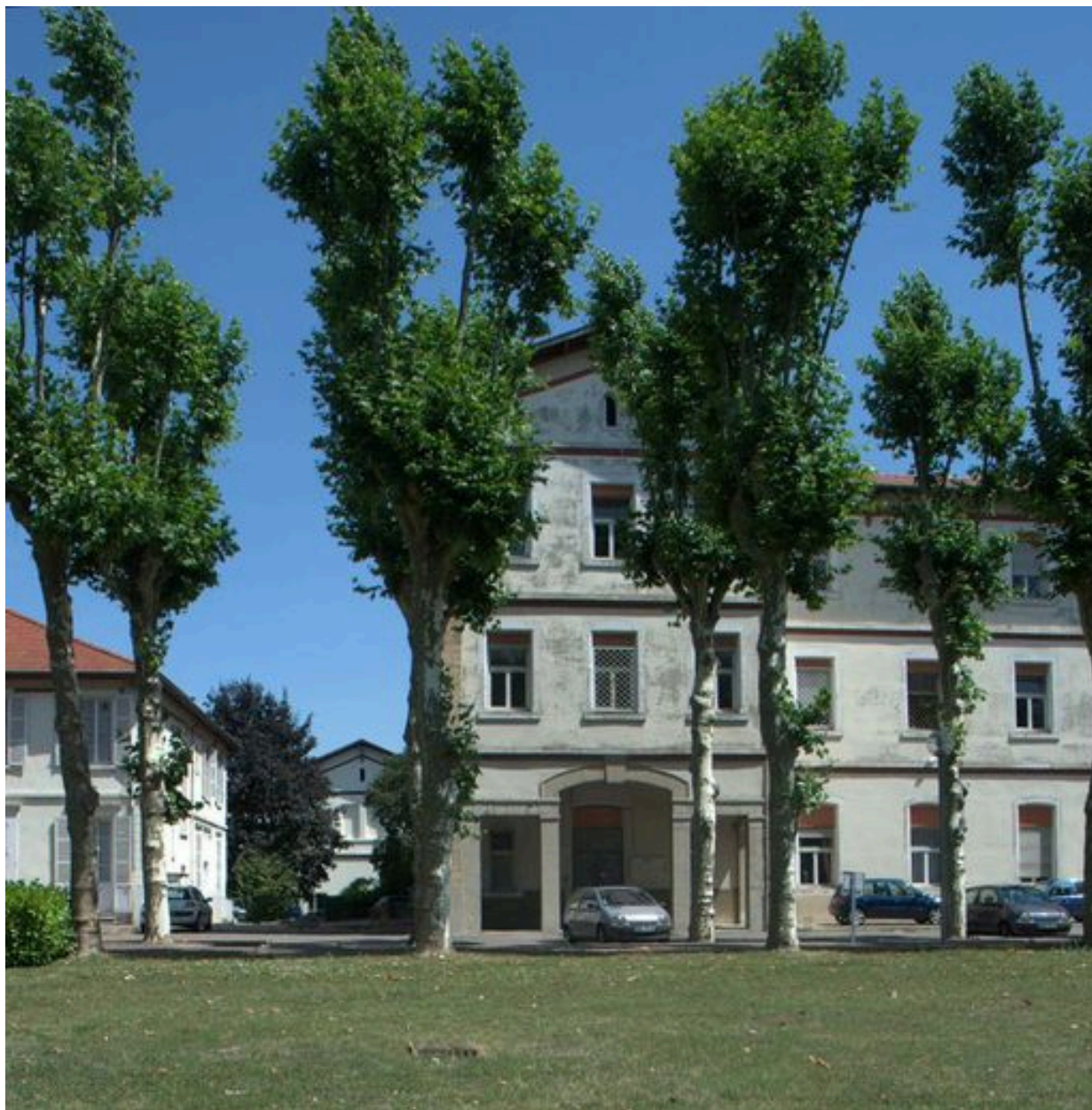
Façade principale (ouest), avant-corps latéral nord
