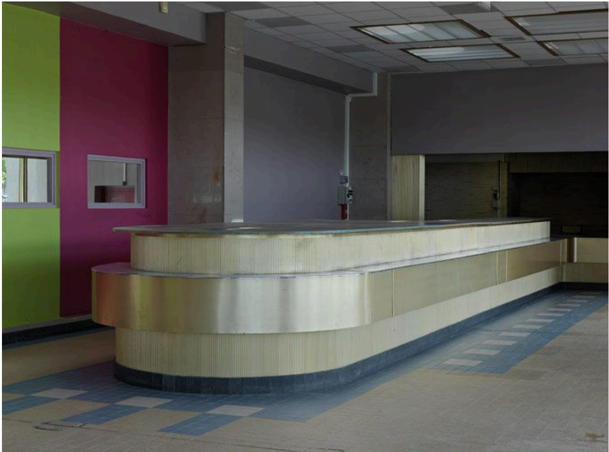
Vue du bar (niveau du quai, état en juin 2012).
