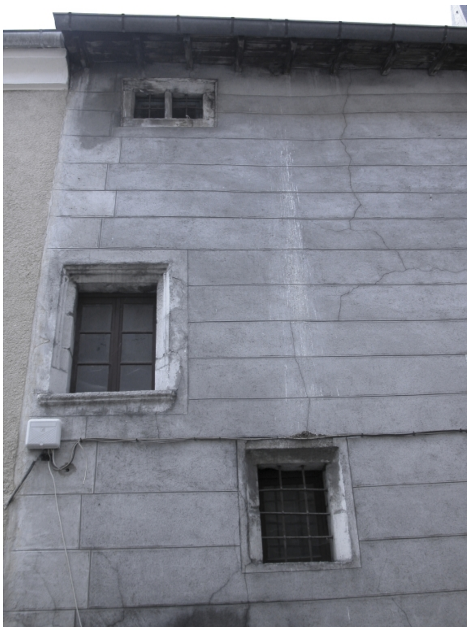
Îlot 10. 8 Mai 1945 (rue du) 01 / Carnot (place). Détail de baie sur la façade du 8 Mai 1945.
