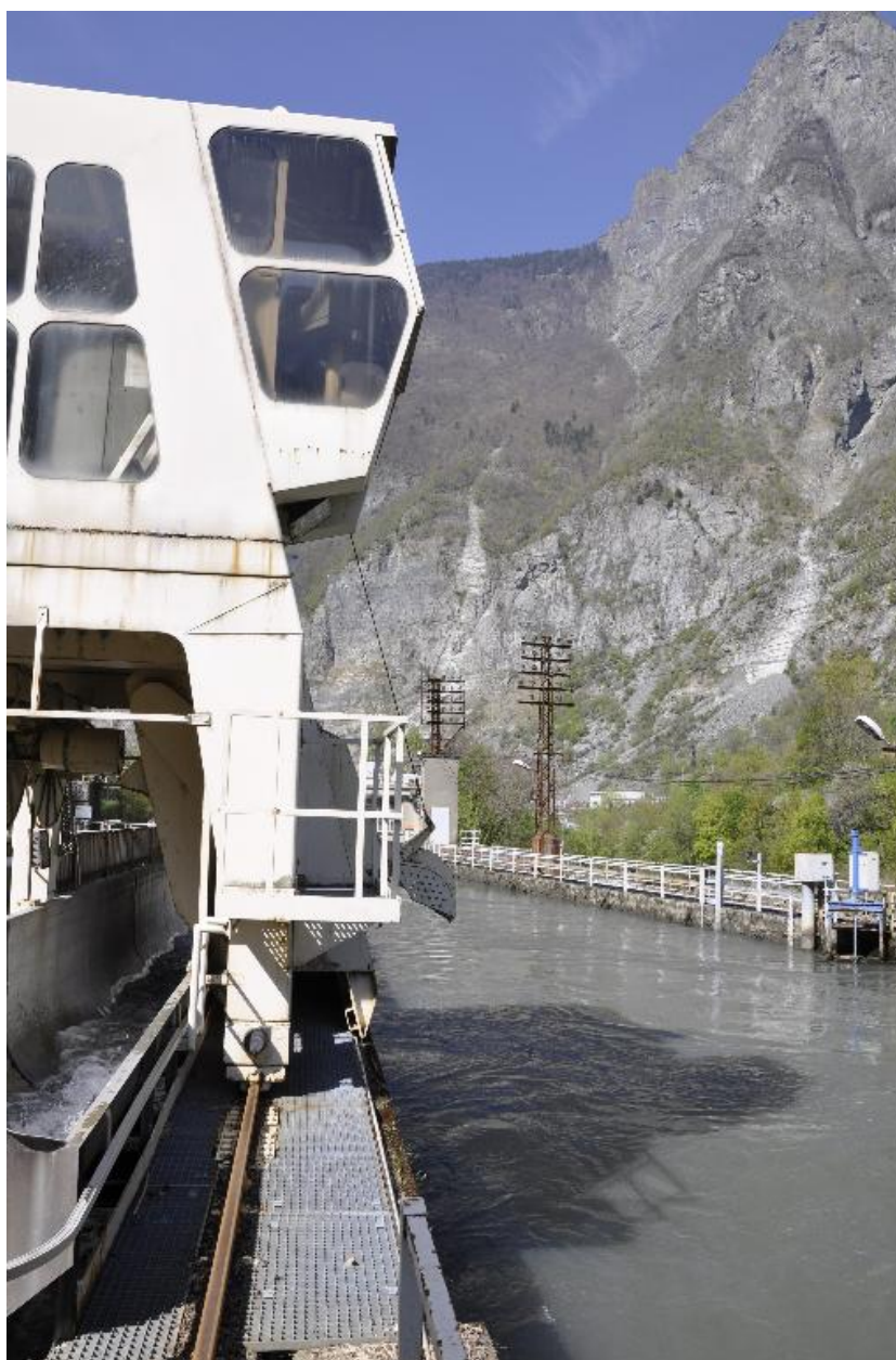
Vue du dégrilleur cabine du barrage de Rioupéroux
